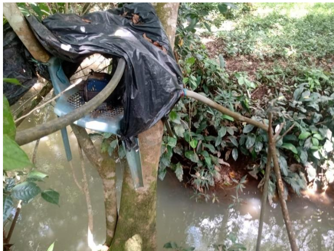
Ilustración 18. Captación artesanal sobre fuente superficial
